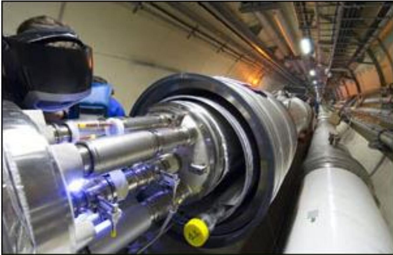
**В современных ускорителях элементарных частиц применяются сверхмощные электромагниты, обмотки которых охлаждаются жидким гелием.**
